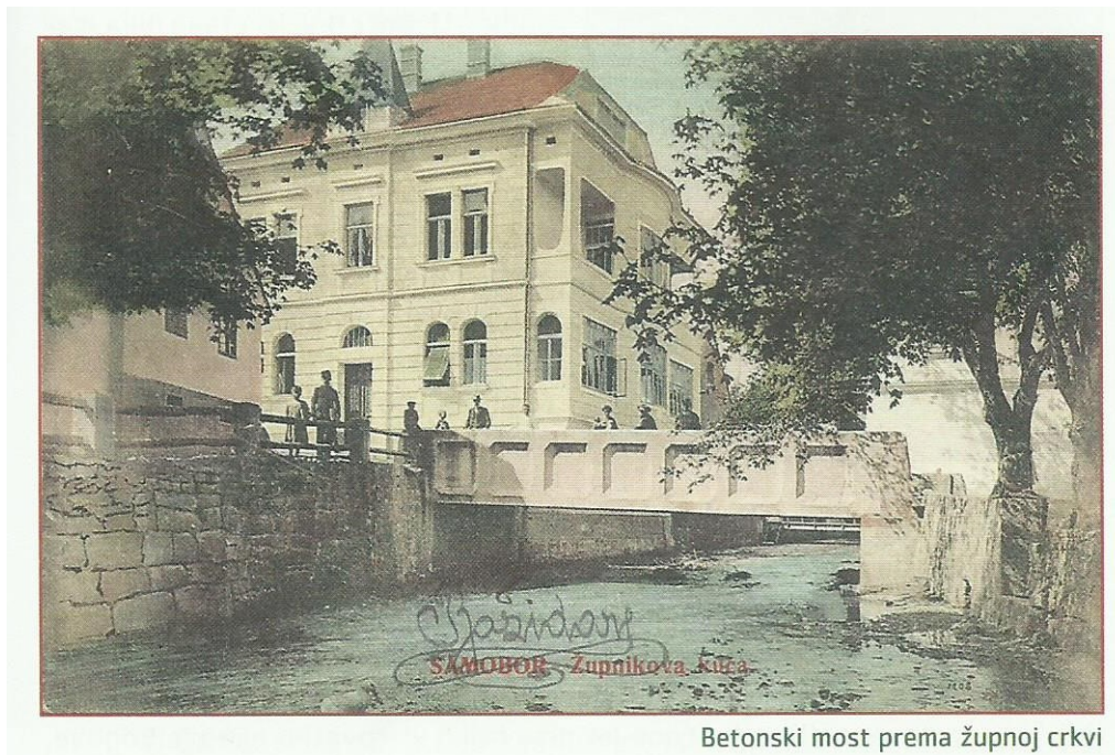
Slika 6. Betonski most prema župnoj crkvi
