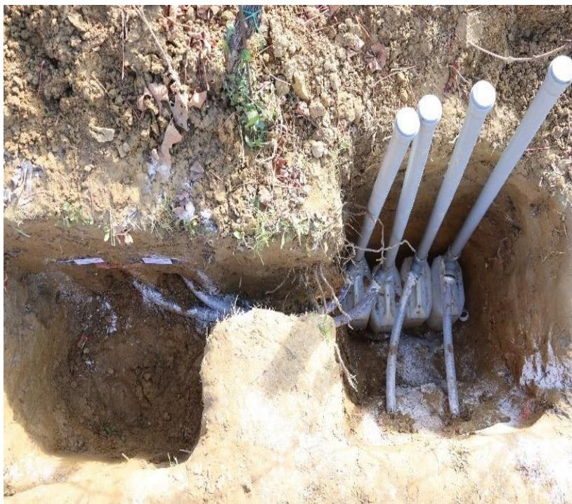
**Slika 3.2.4.**Spajanje armiranih fleksibilnih cijevi sa spremnikom
