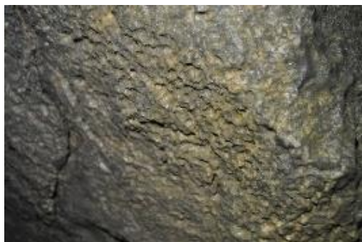
Slika 6.2.1.7.: Kondenzacijska korozija
