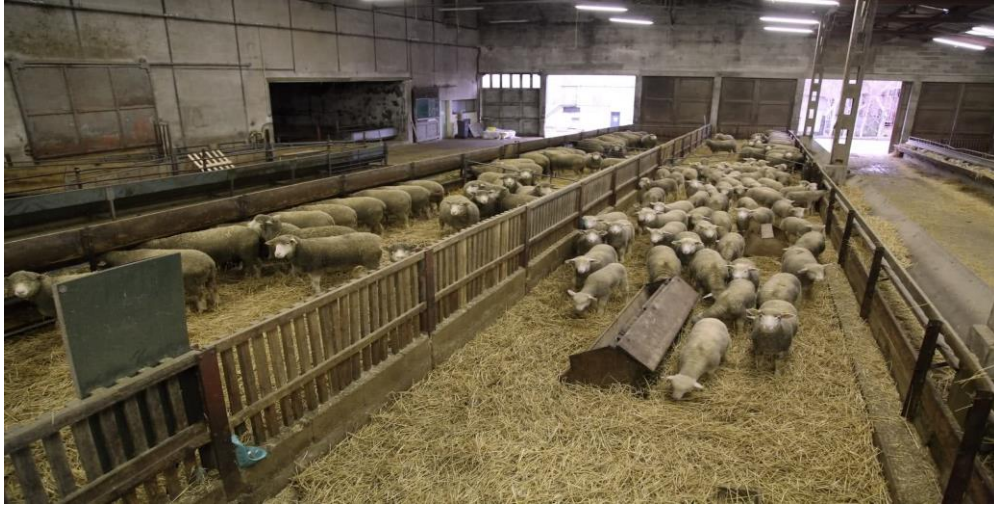
Slika 1.2.2. Objekt za uzgoj ovaca
