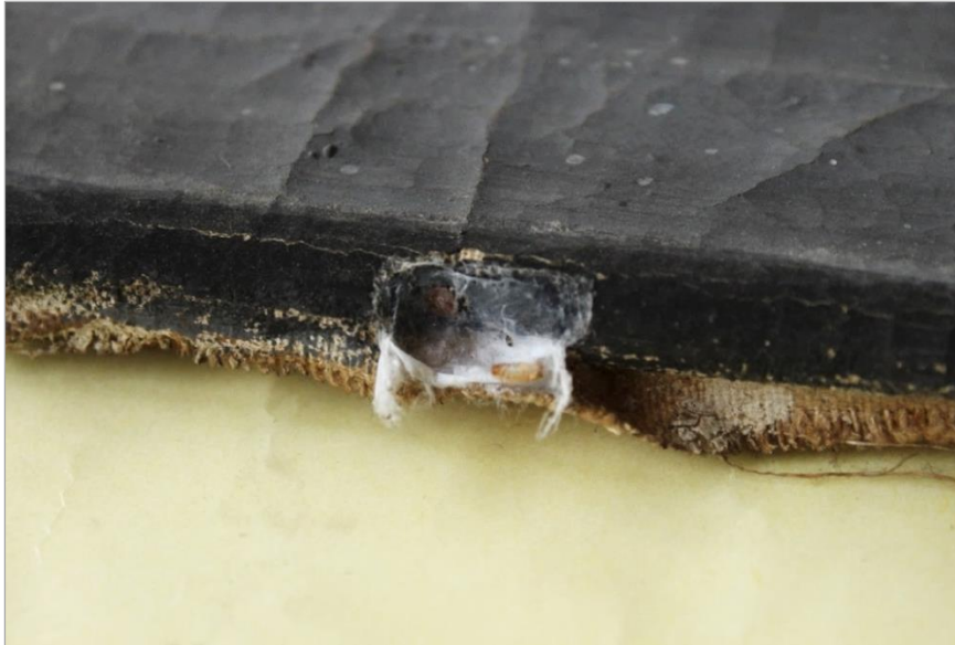
Slika br. 31, fotografija detalja ostatka gnjezda neaktivnih nametnika na rubovima nosioca
