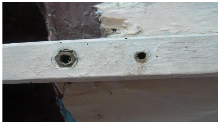
Slika 128. Drvena armatura nakon uklanjanja vijaka, pozadina lijevog krila, u tijeku radova, detalj, fotografirala Hana Knežević 2019.
