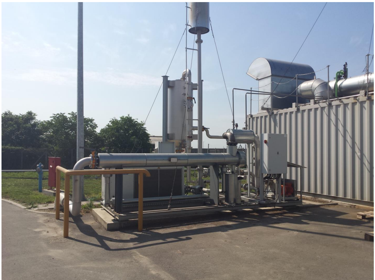
Slika 5.15. Sustav za obradu bioplina i baklja za spaljivanje bioplina [fotografirano 8. lipnja 2015.]
