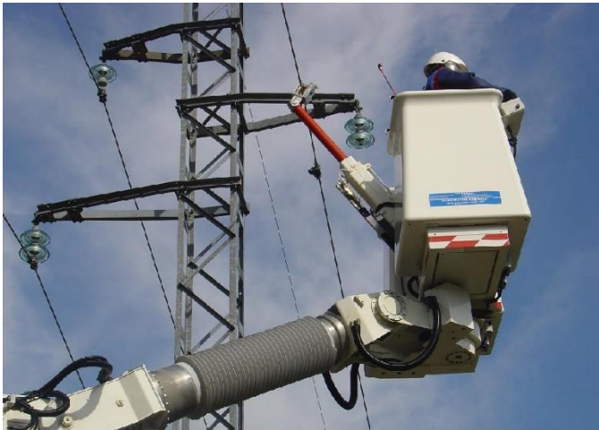
Sl. 3.12. Postupak zamjene izolatora metodom rada „u dodiru“ korištenjem: autoplatforme (lijevo) i izolacijskih ljestava (desno) [7]
