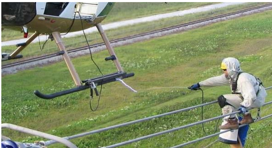
Slika 3.9. Tehnologija RPN metodom „na potencijalu“ [6]
