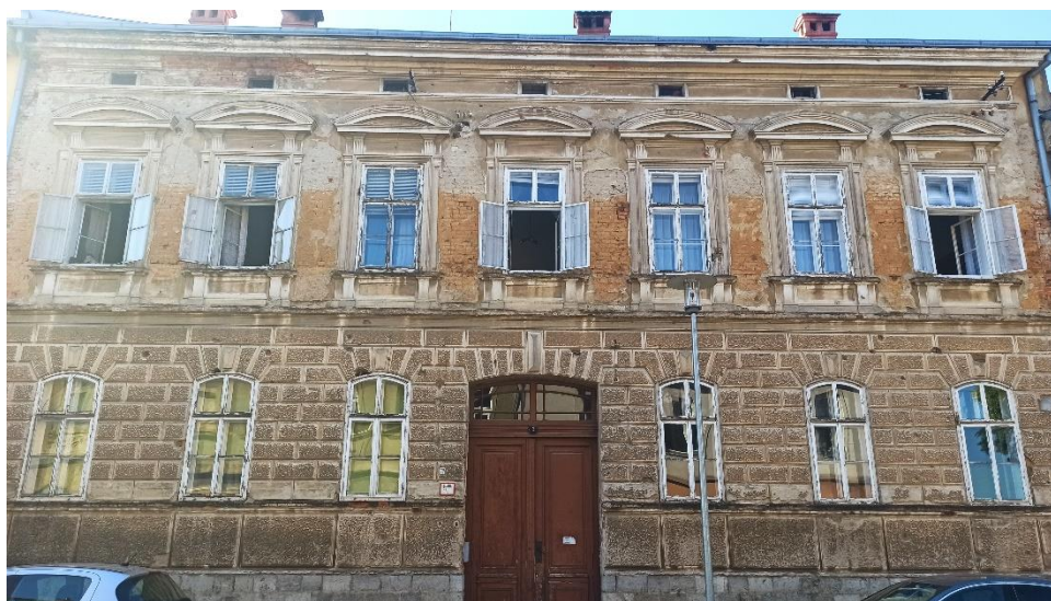
Jednokatnica u Preradovićevoj ulici 3 (Kuća Deak-Lopašić), 1880ih
