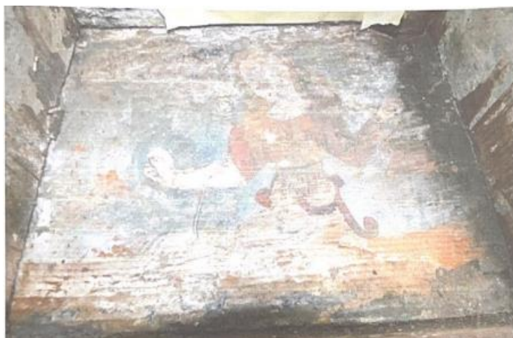
Slika 54. Osluk drvene stropne konstrukcije (Preuzeto iz: Ajduković, Petra; Brakus Kedžo, Anita. Izveštaj provedenih konzervatorsko-restauratorskih istražnih radova u palači Barbieri . Ministarstvo kulture – Uprava za kulturni razvitak (2016.), str. 22)
