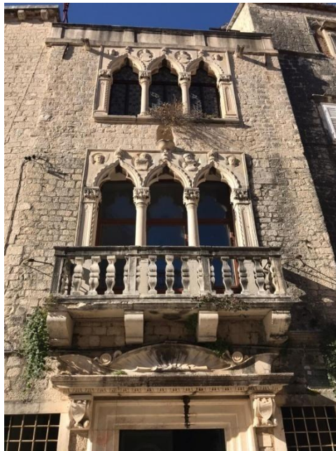
Slika 9. Pogled na trifore istočnog pročelja (snimila: Katarina Galić)
