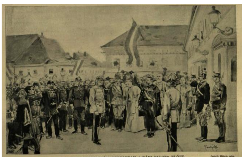
Slika 14. Svečani doček Franje Josipa na otvorenju zgrade HNK u Zagrebu 185
