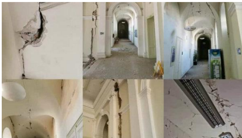
Slika 4. Štete nakon potresa na Pravnom fakultetu
