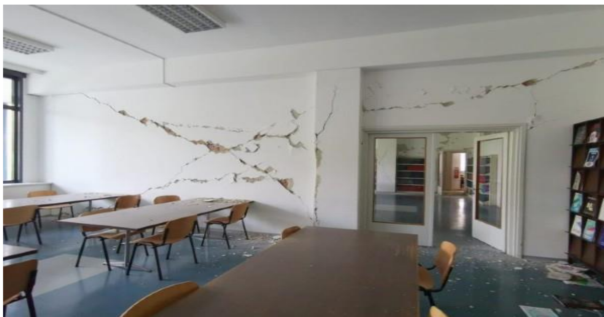
Slika 5. Oštećenje radi potresa – čitaonica SKM
