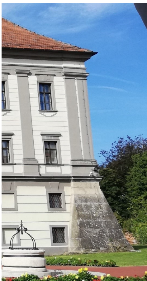
Slika 8a: Dvostruki pilastri iznad kontrafora
