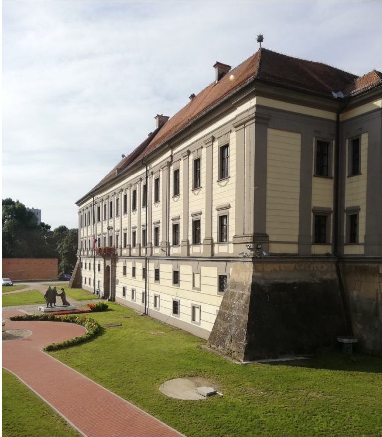
Slika 7: Pogled sa sjevera na kontrafore sjeveroistočnog krila
