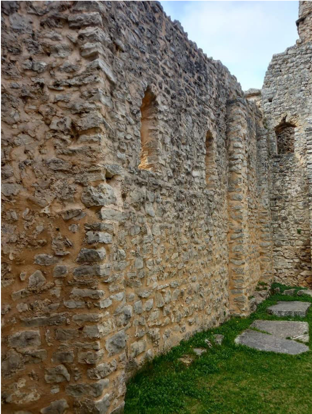
Slika 15. Raščlanjenost unutarnjeg plašta crkve Sv. Spasa, detalj južnog zida. Foto: Jelena Milošević
