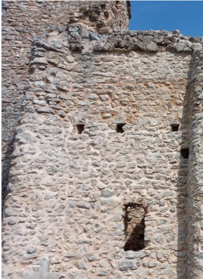
Slika 11. Rupe od drvene skele, detalj na južnom zidu crkve Sv. Spasa. Foto: Jelena Milošević
