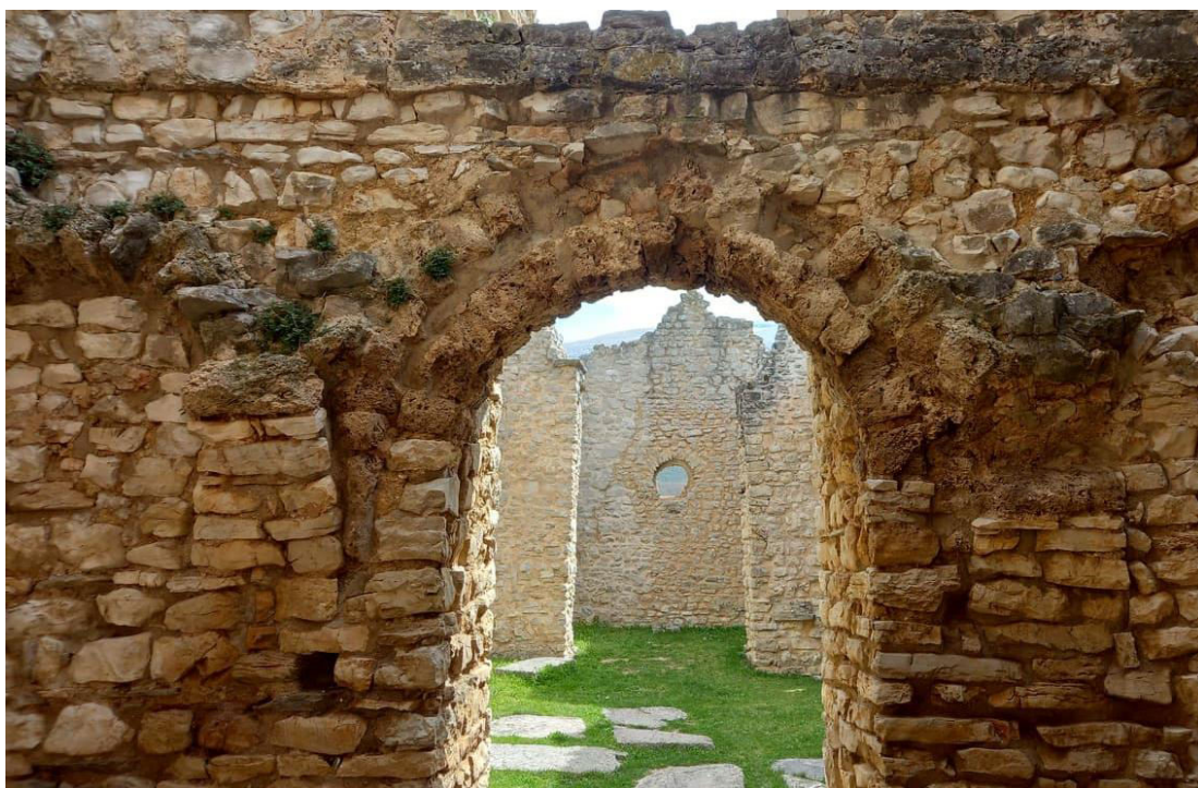
Slika 19. Raščlamba prostora i ostatci svodova u prizemlju westwerka crkve Sv. Spasa. Foto: Jelena Milošević
