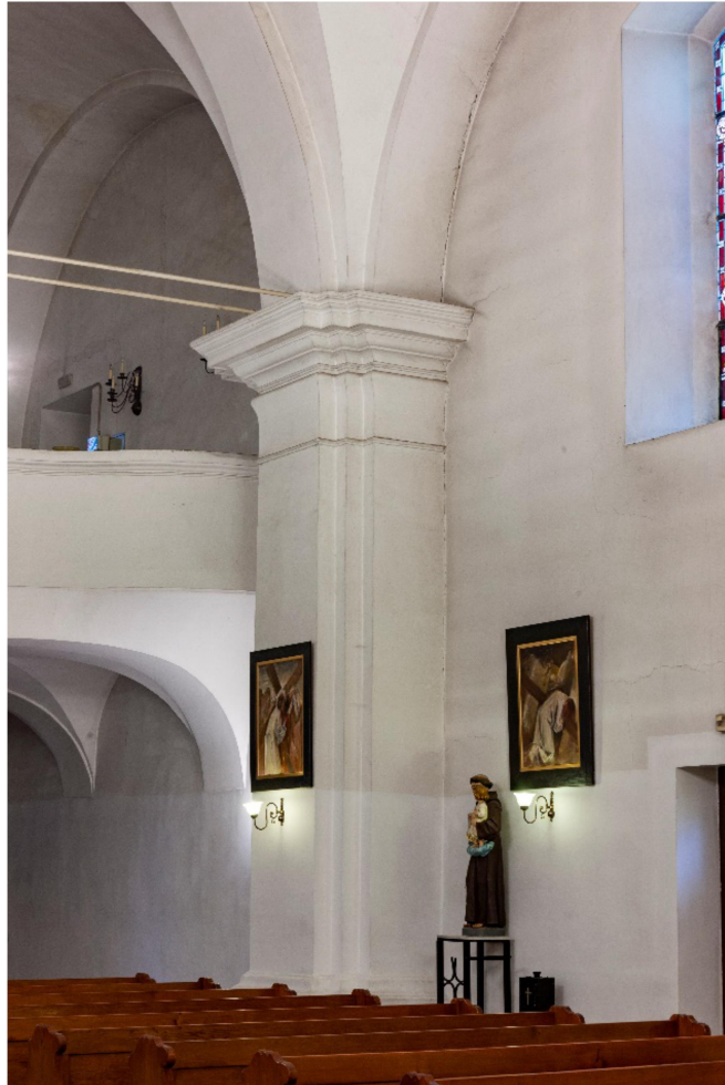
Ilustracija 18. Stub u brodu sa prizidanim pilastrima 2019. godine
