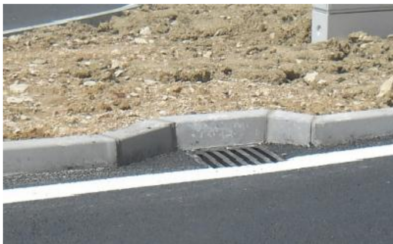
Slika 7. Prikaz učinkovitog prikupljanja oborinske odvodnje
