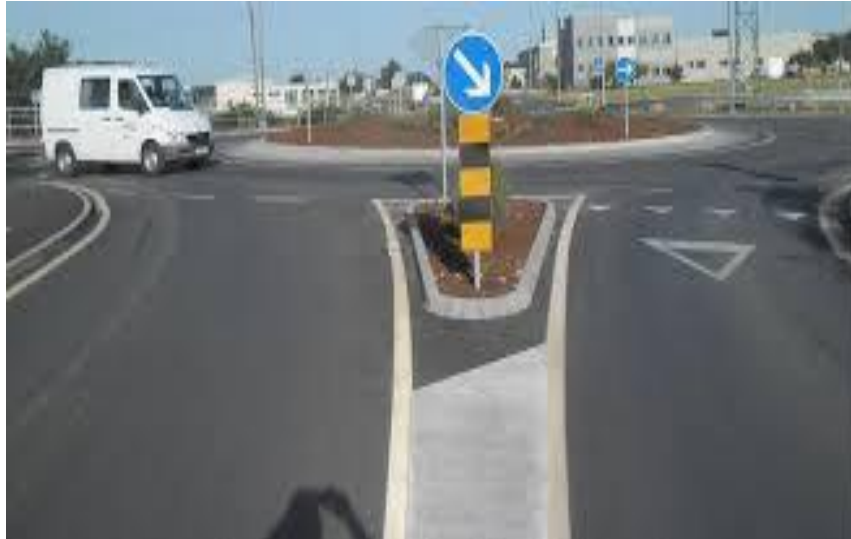
Slika 5. Razdjelni otok unutar površine za razdvajanje prometa
