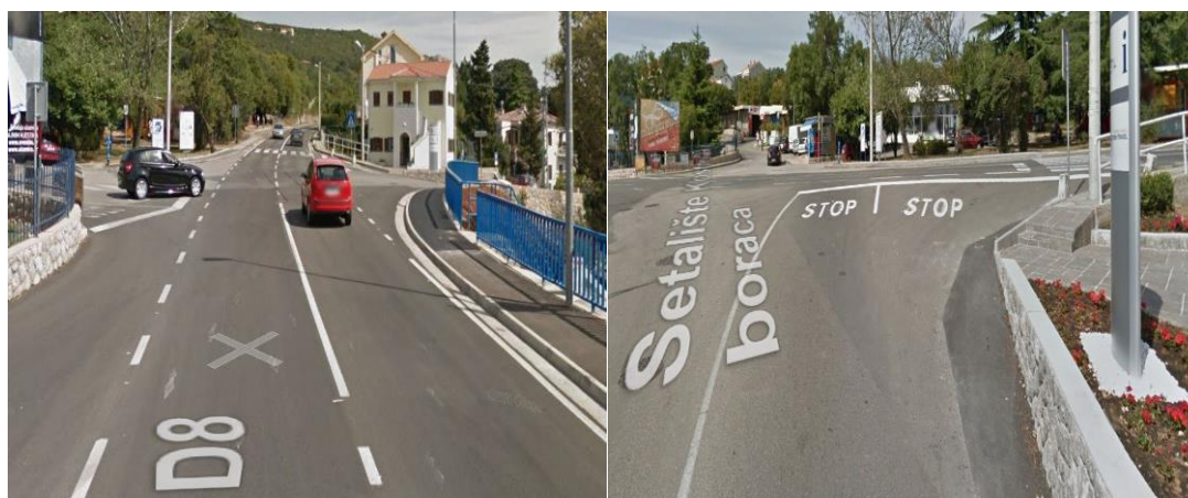
Slika 21. OM Šodići – prije sanacije
