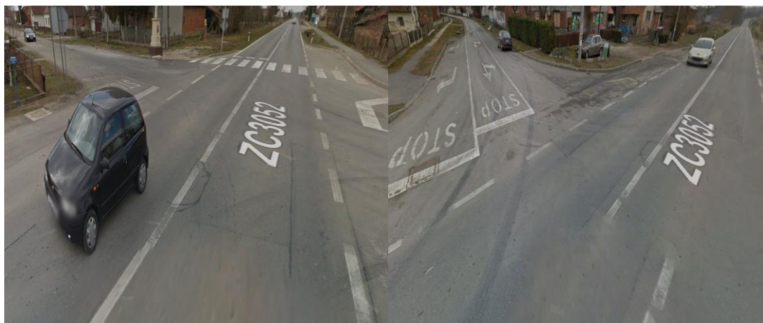
Slika 18. OM Severin – prije sanacije
