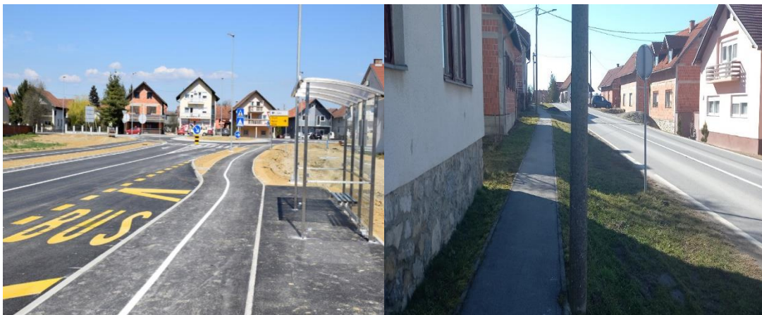
Slika 25. OM Pakrac – poslije sanacije
