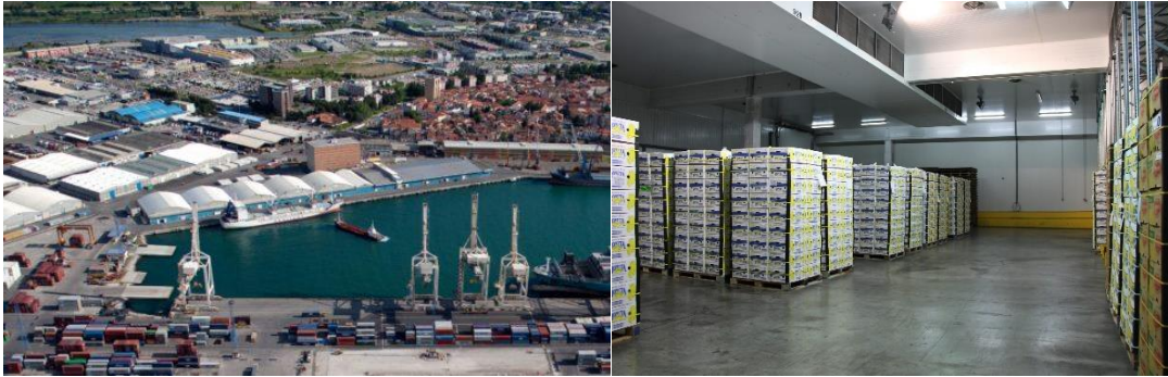
Slika 18. Terminal za rashlađeni teret u luci Kopar Izvor: [24]
