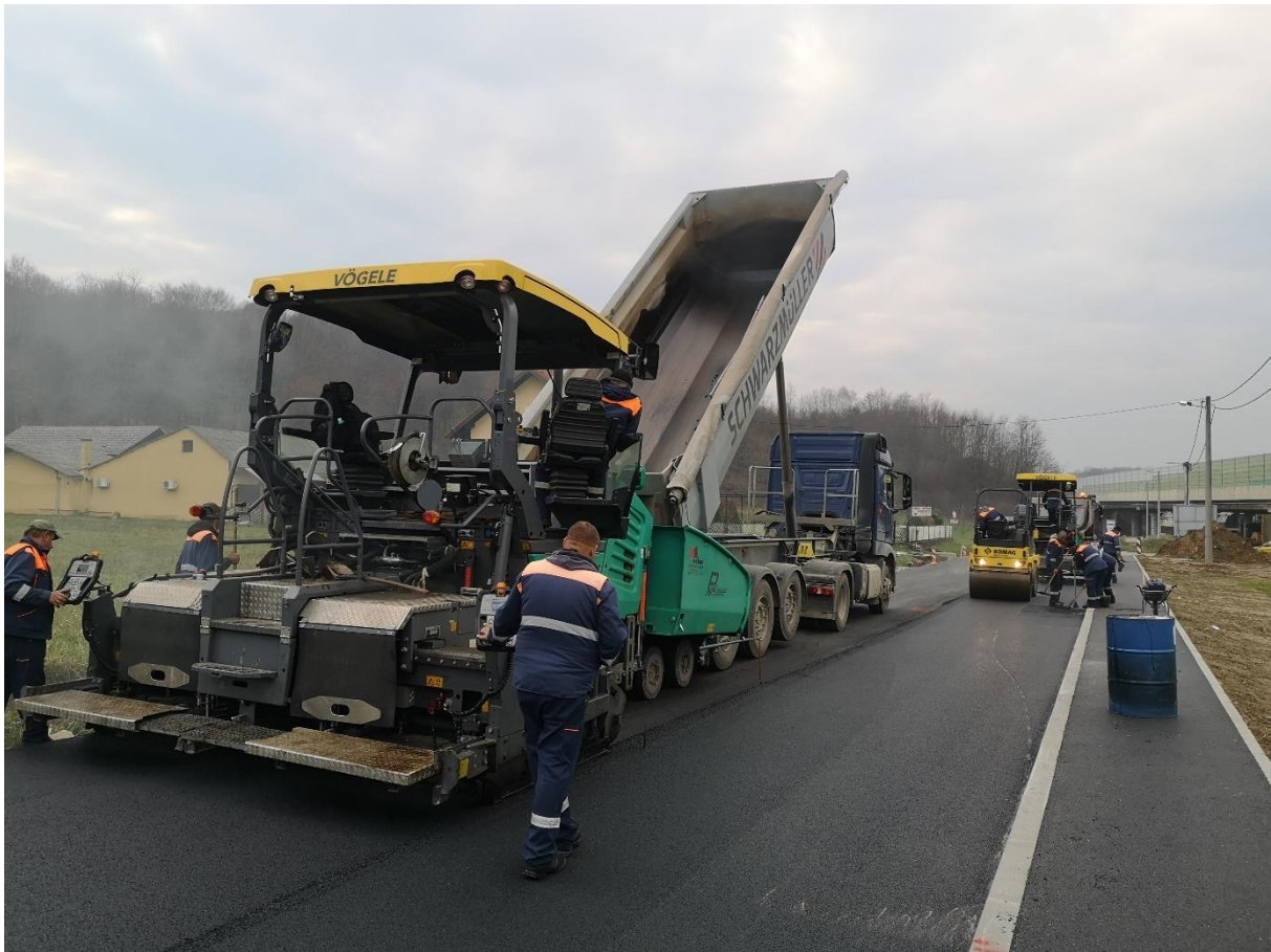
Slika 9. Postavljanje asfalta
