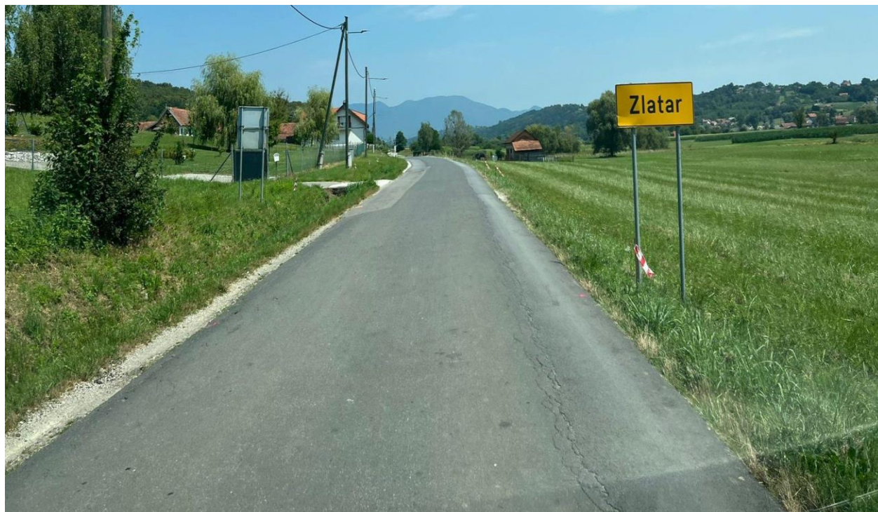
SLIKA 5. STANJE KOLNIKA PRIJE REKONSTRUKCIJE NA LOKALNOJ CESTI LC22053 (ZLATAR (DC29) – LOVREČAN (ŽC2264))
