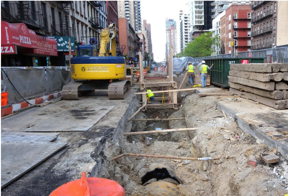
Slika 2. Prikaz radova na ulici prilikom izgradnje metroa
