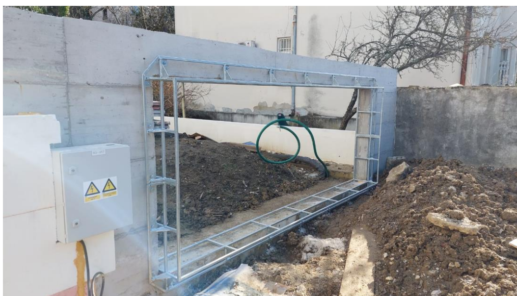
Slika 26. Prikaz montirane konstrukcije
