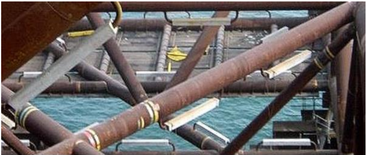
Slika 12. Prikaz katodne zaštite žrtvovanom anodom [15]
