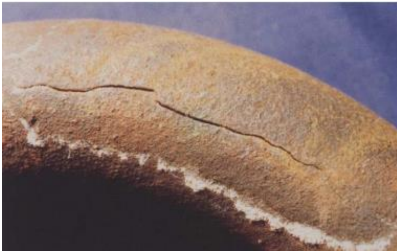
Slika 5. Napetosna korozija na cijevi [6]
