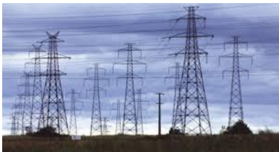
Slika 19 Dalekovod kao tipični primjer pocinčanog čelika [18]
