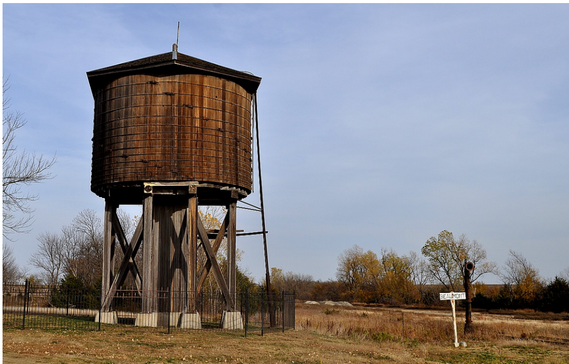
Slika 1. Vodotoranj izgrađen 1875. g. u Kansas-u, SAD
