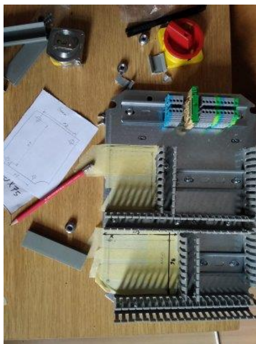
Slika 29. Montiranje uzdužnih kabljskih kanala
