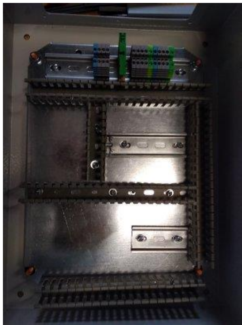
Slika 28. Montiranje nosača
