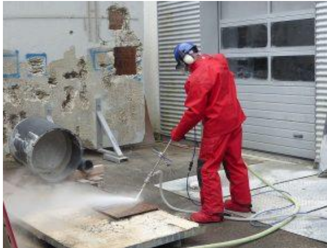
Slika 6.4. Čišćenje površine mlazom vode [27]
