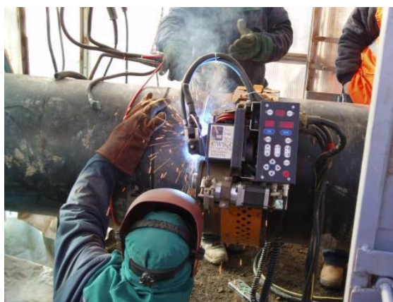
Slika 7.5 Glava za zavarivanje [35]
