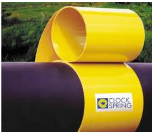
Slika 7.12 Ugradnja "clock-spring" obujmice [46]
