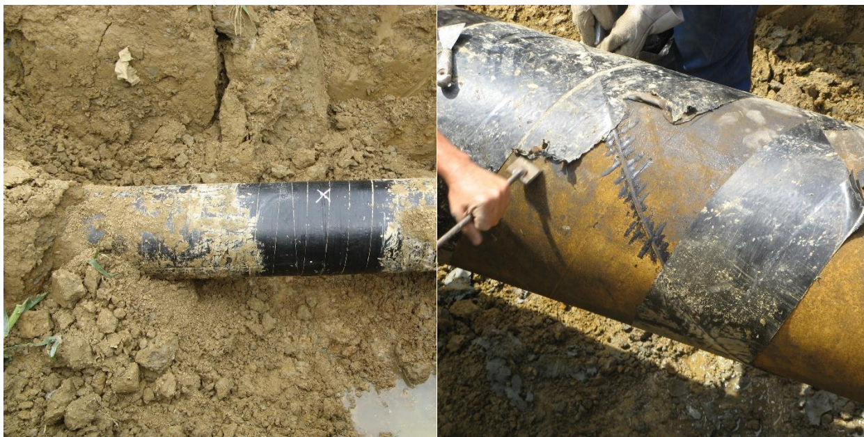
Slika 9.14 Iskopano mjesto oštećenja i skidanje izolacije [33]
