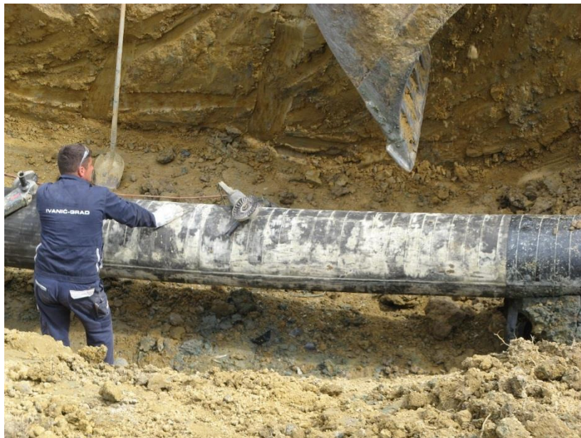
Slika 9.11 Skidanje izolacije i čišćenje cijevi [33]
