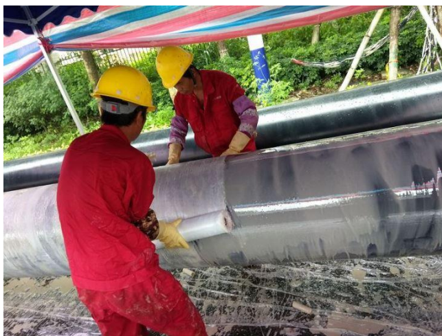
Slika 16. Oblaganje cijevi staklenim vlaknima [26]
