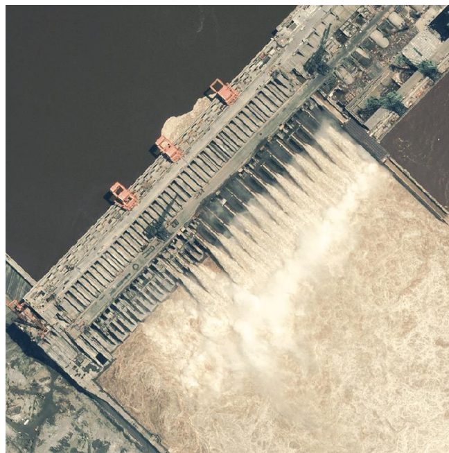
Slika 4. Pogled odozgo na hidroelektranu Tri klanca ( dio kontrole poplava ) [18]
