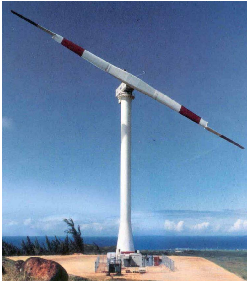
Slika 20. Vjetroturbina MOD- 5B (3,2 MW) [27]
