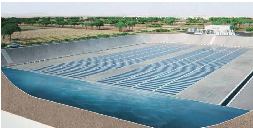
Slika 3.3 Primjer postavljenog FPV sustava na vodi [11]
