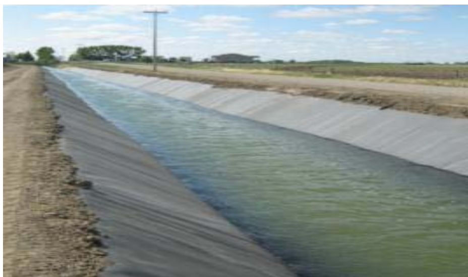
Slika 8. Obloga od plastičnih sintetičkih folija (geomembrana) [12]
