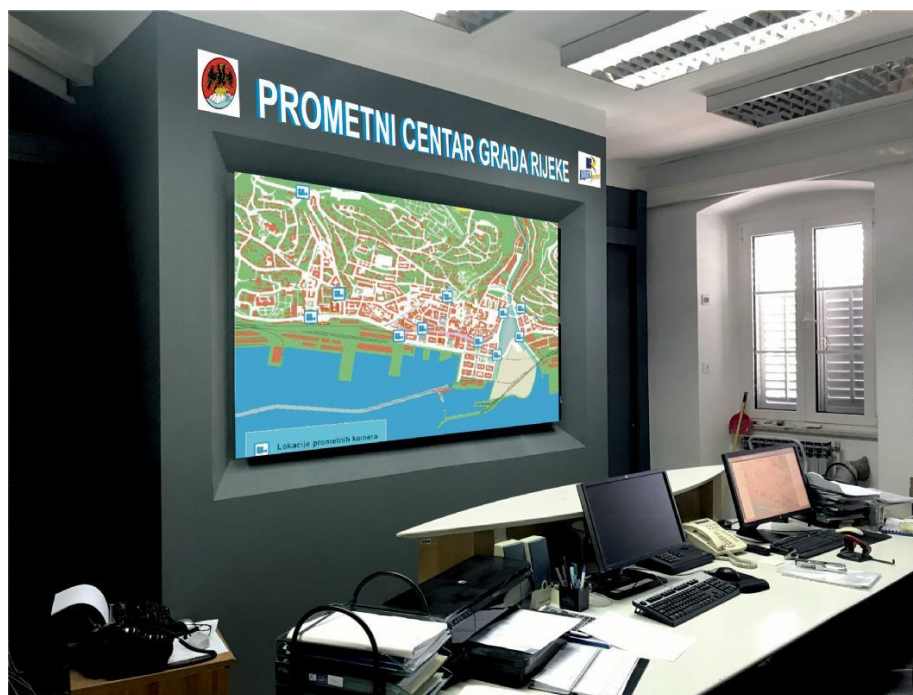
Slika 11. Sustav automatskog upravljanja prometom grada Rijeke [31]
