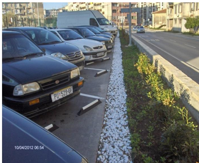
Slika 8.: Infiltracijski jarci parkirališta (Izvor: [6])
