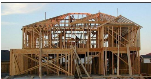
Slika 23. Suha gradnja – platformframe konstrukcija
