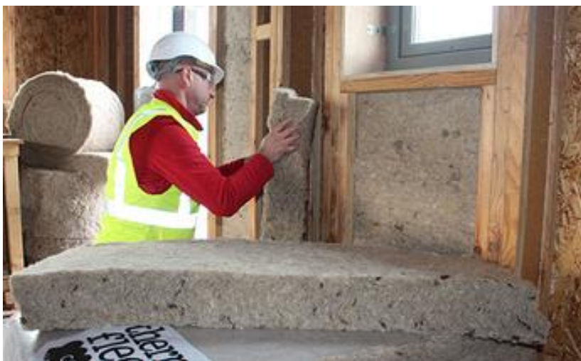
Slika 2. Postavljanje ovčje vune
