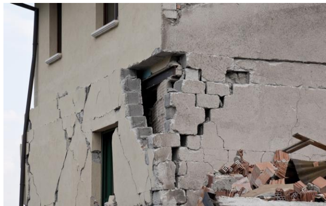
Slika 6. Slom ugla nakon potresa u Petrinji 2020.godine [8,10]
