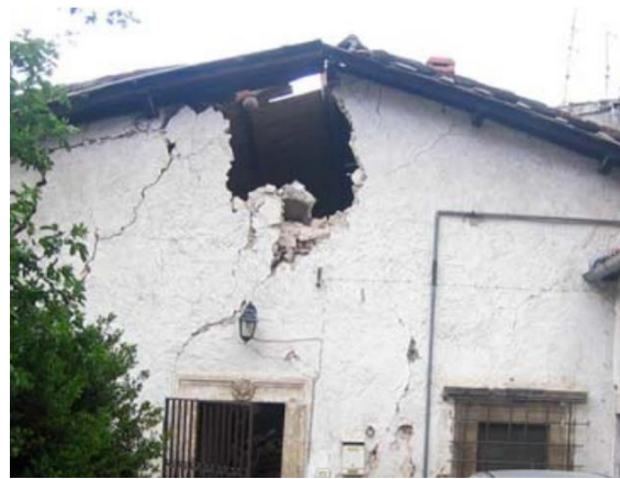
Slika 18. Prevrtanje lastavice zabata: shema [2], primjer [1]
