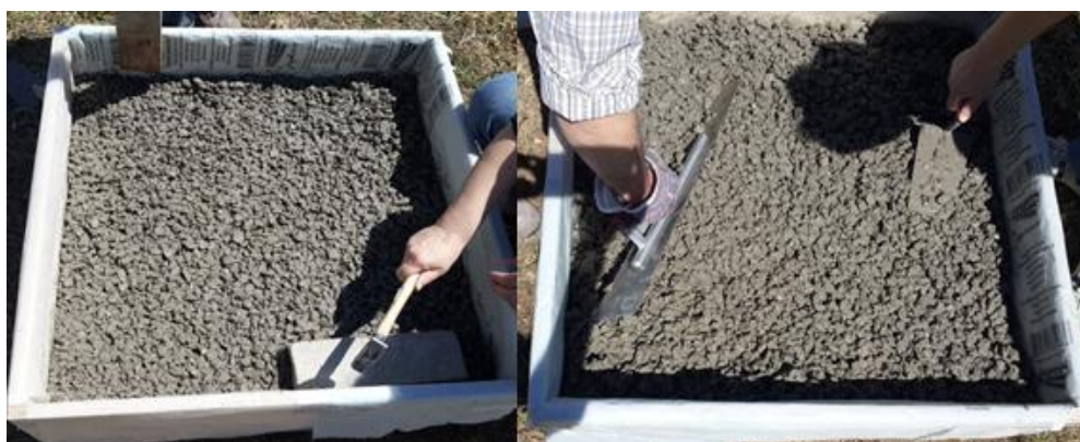
Slika 4.16 Proces ugradnje porozno – betonskih ploča [26]
