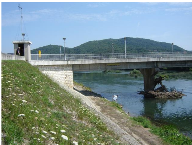
Slika 3.10.: Mjerna stanica Kostajnica na rijeci Uni
