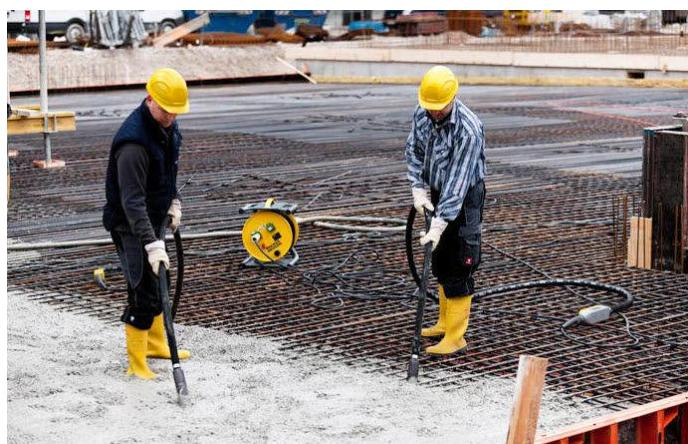
Slika 5.3. Korištenje vibro igle pri zbijanju betona [14]
