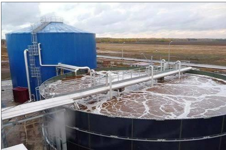
Slika 6. Prikaz spremnika za biološku obradu otpadnih voda [26]
