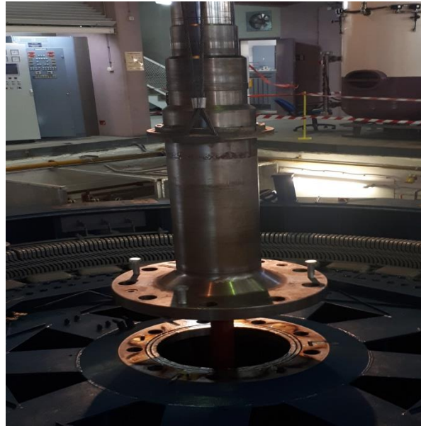
Slika 4. 9. Osovinski nastavak [15]
