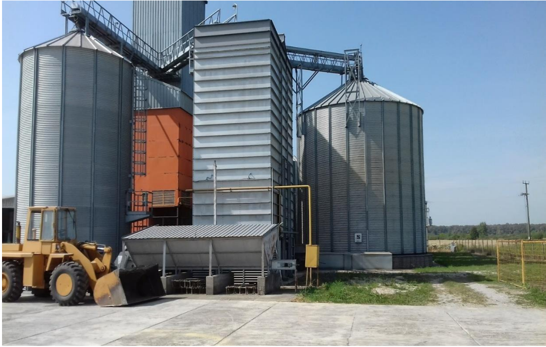
Slika 4. Silos u Drenovcima (850 t) (Foto: Oliver Kandrać)
