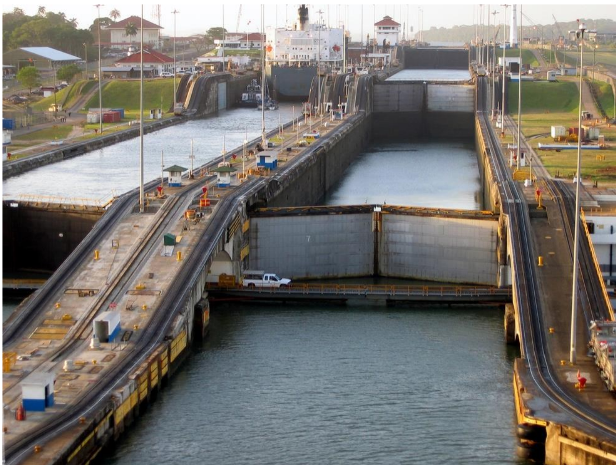
Slika 4. Prevodnica na Panamskom kanalu
