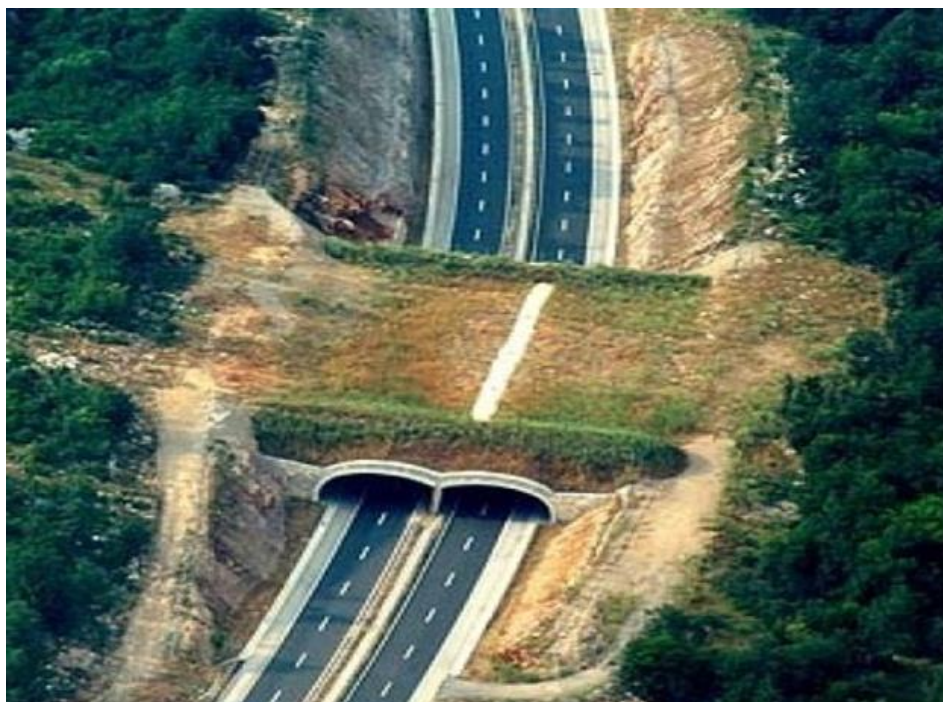
Slika 4. Primjer Zelenog mosta na autocesti A1 ( http://www.geografija.hr/hrvatska/utjecaj-izgradnje-autocesta-na-fragmentaciju-stanista/ )
