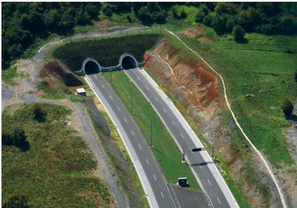
Slika 14. Tunel Brinje ( izvor: http://www.gin.hr/hr/projekti/infrastruktura/tunel-brinje-(autocesta-zagreb---split),51.html )
