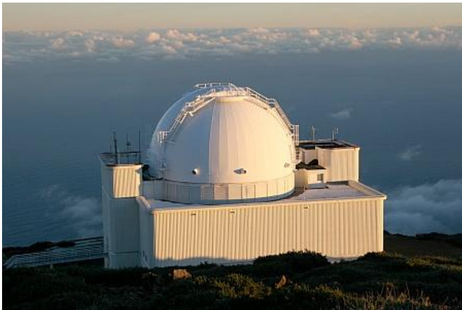
Slika 7.1. Kupola Isaac Newton teleskopa (INT) na La Palmi.
