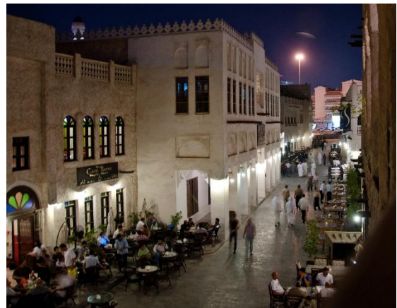
Sl.11. Souq Waqif nakon obnove
