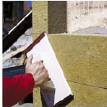
Kontaktni toplinsko izolacijski sustav
