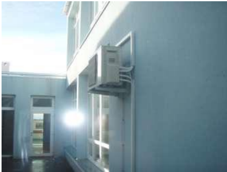
Slika 51. Vanjska jedinica split sistema
