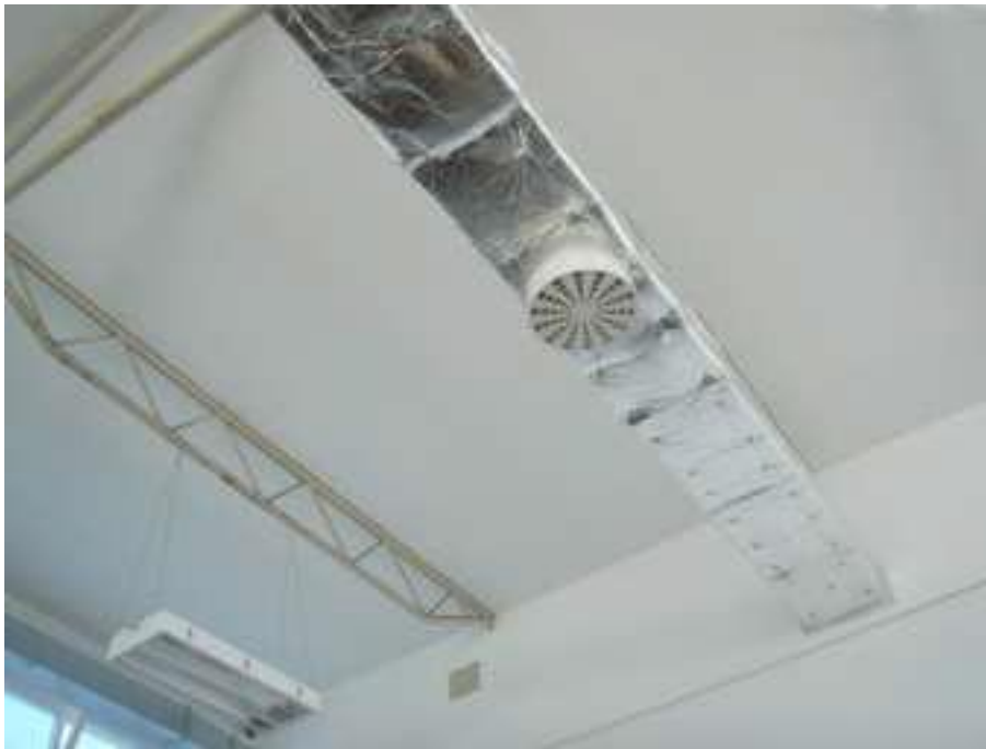
Slika 48. Tlačna ventilacija
